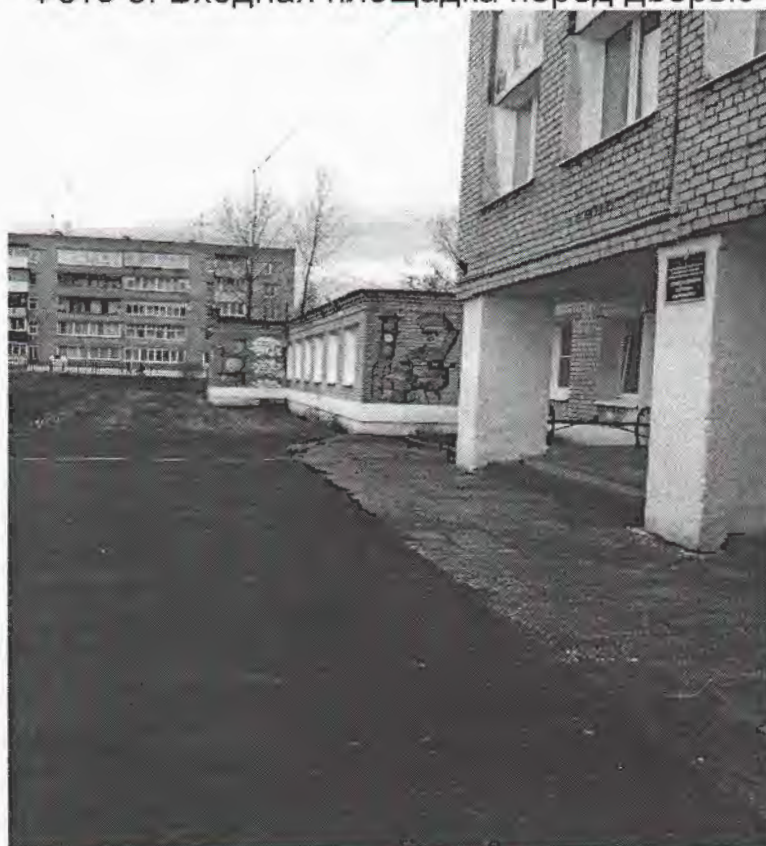
Фото 5: Входная площадка перед дверью
